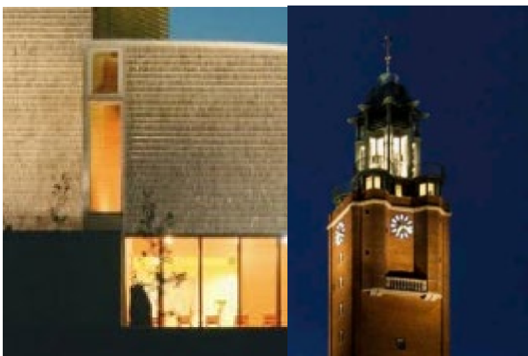
Effektbelysning Viiki kirke, Helsinki og Frederiksberg rådhusårn
